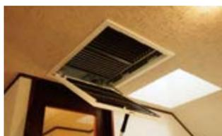
天井に設置された電子式エアクリーナ。一般的なフィルタでは取れない0.01μm単位のマイクロダストやウィルスまで除去。開閉も簡単で月1~2回の清掃もラクに行える
