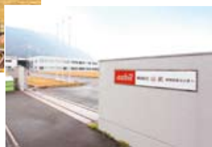
筑豊の豊かな自然の中にある香春技術センター。立会検査で来られたお客さまには、コントロールバルブの点検作業なども公開し、山武のメンテナンス体制をご覧いただいている。
