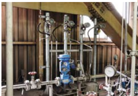
アルゴンと窒素の切替えを行うトップガイド形単座調節弁 CV3000 Alphaplus™。
