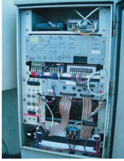
地震センサで計測したSI値などのデータが東京ガス管内4000カ所の地区ガバナステーションからデータコレクタ DCX350を介してセンターへ無線送信される。
