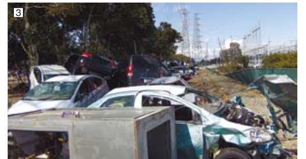
① 仙台市内で被災した病院の空調の中央監視装置。津波をかぶり大破している。公共性の高い施設から集中的にBSCが立上げを支援している。 ② プレーカヤリレー回路などが取められた制御盤も津波で水に浸かり、使えない状況となった。 ③ 街の中の至る所が、津波で押し流されたがれきりや車で埋め尽くされている。
