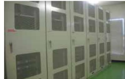
尾張東部浄水場に設置された広域送水監視制御システムのセンター局サーバー。各地に分散している浄水場や調整池、供給点などで計測した水量、水圧、水質などの情報を収集し、管理を行う。
