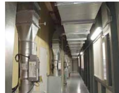
動物飼育・実験エリアの外廊下に設置されているInflex VN。動物飼育室の各部屋単位にInflex VNを設置し、給排気を連動させた風量体積制御と室圧補正制御を行っている。
