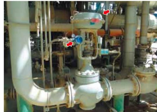
砂嵐が吹くような過酷な環境で、安定稼働を続けるアズビルのプレッシャーバランス形ケージ調節弁 CV3000とスマートバルブポジションナ AVP3000 Alphaplus。
