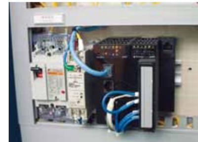
エネルギー消費状況を把握するために設置された電力計、ガスメーター、温湿度センサ、エア流量計からデータを収集するコントローラ、計装ネットワークモジュール NX。
