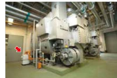
ガス焚冷温水発生器にアズビル金門製の大型ガスメーターを設置し、ガスの使用量を計測する。
