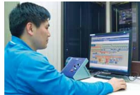
中央監視室に設置されたsavic-net FXの監視端末。水槽内の水温などを一元的にモニタリングしている。
