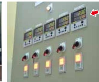
デジタル指示調節計。温度センサなどの計測値を基に、水槽の温度制御を行う。
