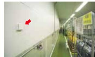
検定検査室の温湿度を適正に保つ制御を行うデジタル指示調節計 SDCシリーズと検定検査室内に設置された室内形温度/湿度センサ ネオセンサ。
