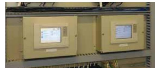
熱源管理用デジタルコントローラPARAMATRIX™4。負荷側の需要に合わせてヒートポンプチラー、冷水／温水ポンプの台数制御を行う。
