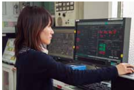
Harmonasの監視端末を事務所、保安室に設置。それぞれの場所でコンプレッサなど機器の稼働状態が確認できる。
