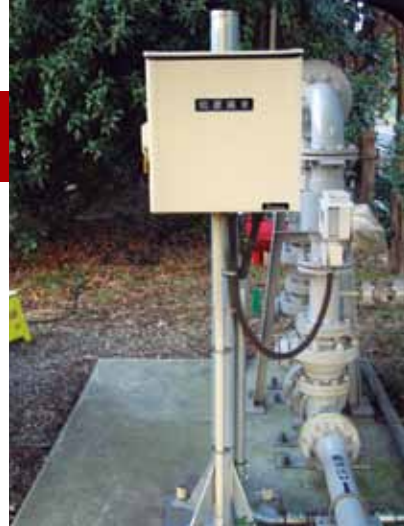
顧客側の機器設置例。取引用のパルス発信機能付きメーターの近くに伝送端末を設置。流量の計測を通信機能付きデマンド計が行い、伝送端末機から本社のセンターシステムへデータを送信する。
