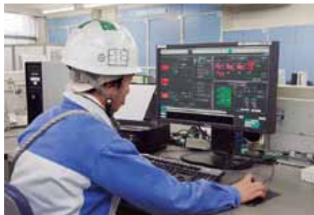
Harmonasの監視端末を事務所、保安室に設置。それぞれの場所でコンプレッサなど機器の稼働状態が確認できる。
