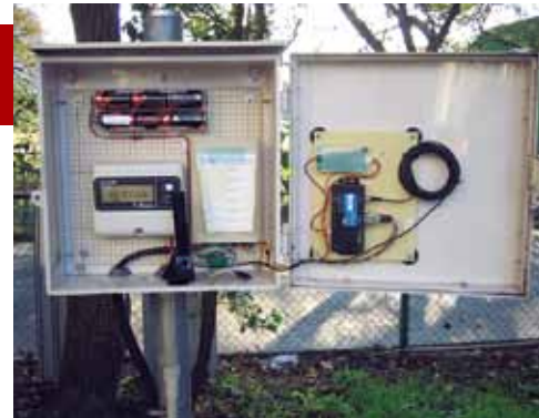
顧客側の機器設置例。取引用のパルス発信機能付きメーターの近くに伝送端末を設置。流量の計測を通信機能付きデマンド計が行い、伝送端末機から本社のセンターシステムへデータを送信する。
