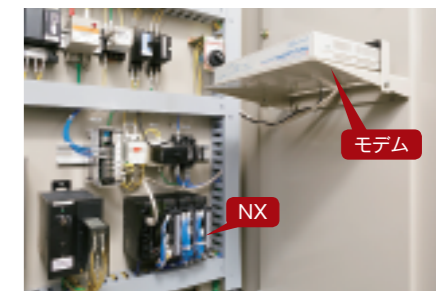
和田低区配水池に置かれた計装盤内。NXがモデム経由でアナログ回線を介して庁舎電算室にあるゲートウェイのDGPL IIに接続している。
