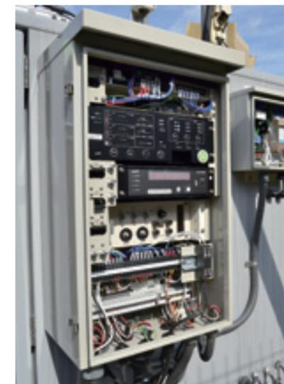
遮断/再開双方のバルブ制御を可能とする開閉制御ユニットSES71Z。
