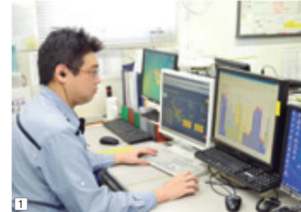
1 中央監視室に設置されているsavic-net FXとビルマネジメントシステム savic-net FX BMS。水槽など飼育施設の温度、水位を含む建物全体の設備の稼働状況を可視化し、施設運営にかかわる省エネルギーの実現を支援。飼育員のために飼育施設のみならず、参照できる画面レイアウトを用意するなど、職務に応じた監視のしやすさを追求するといった工夫も施されている。
