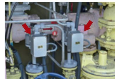
地区ガバナ設備への取付けが進められている、開閉操作を自在に行えるバルブBSV。
