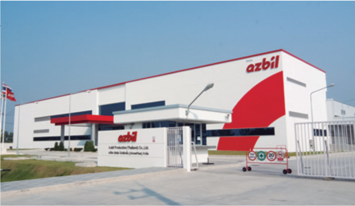
タイ中部のチョンブリー県にあるアマタナコン工業団地に建設された新工場。
