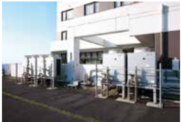
新館南側に設置されたヒートポンプ給湯器。
