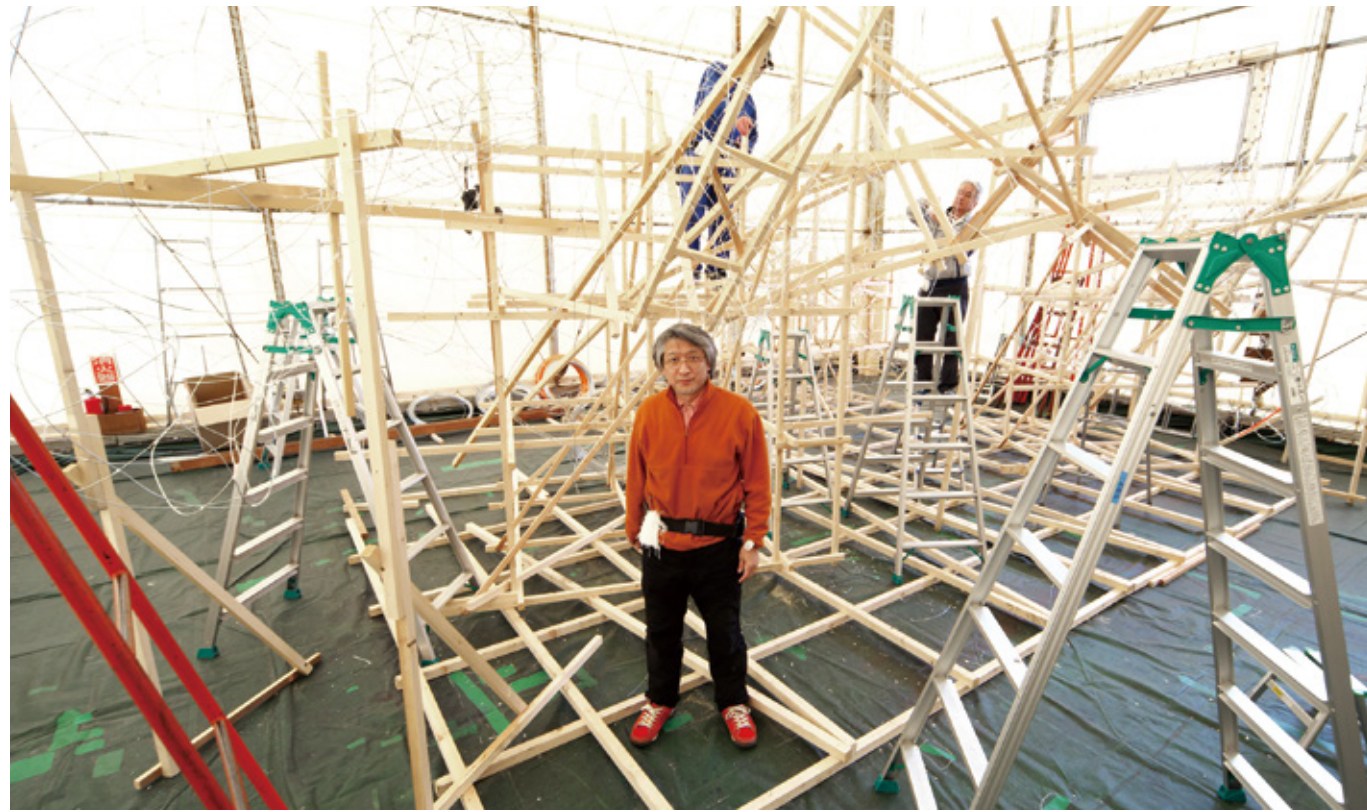
骨組み作業では、角材で支柱を作り、和紙が貼れるように針金などで形を作っていく。
