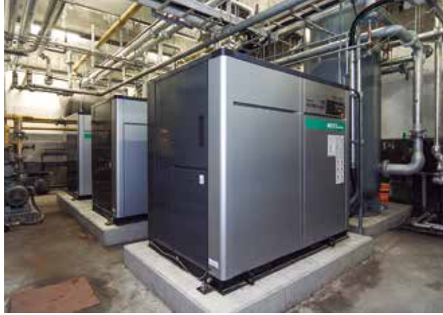
三つあるコンプレッサ室の一つ。コンプレッサの設置位置や複雑化していた配管を見直し、レシーバータンクを含めて再設計を行った。
