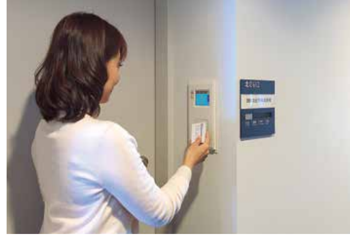
教員は研究室入り口でICカードをリーダーにかざして施錠／解錠を行う。また、カードリーダーの液晶パネルで「学内（講義中）」「外出」などを選択することで、エントランスに設置された出退表示液晶ディスプレイの情報が自動で切り替わる。
