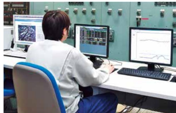
計器室に設置されたSORTiA-MPC(中央、右)とsavic-net™FX(左)。SORTiA-MPCでは、4基ある発電設備の運転最適化を行っている。また、savic-net FXは、アズビルのセンターと接続して運転データを蓄積し、運転状況を可視化することができる。
