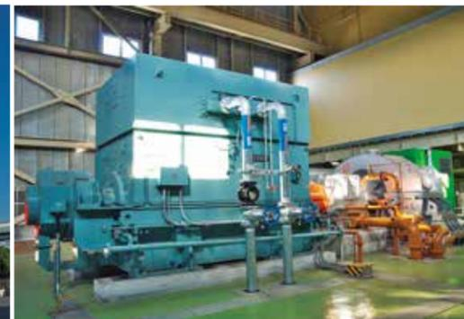
バイオマスの自家発電設備(左)とバイオマス発電機内のタービン(右)。バイオマスチップをボイラで燃やし、その熱で蒸気を発生させ、その蒸気でタービンを回して発電を行う。同時にタービンの途中段からは蒸気を抽気(ちゅうき)し、この抽気を生産プロセスへと供給する。
