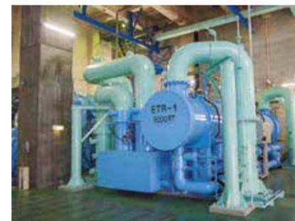
中央冷暖房所のプラント内にある電気式冷凍機。
