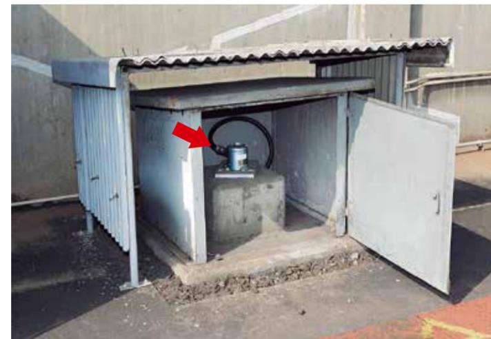
プラント内の3カ所にインテリジェント地震センサSES70が設置されており、信号を受信するコントローラ側で多数決(2-out-of-3)処理により地震を判定する。
