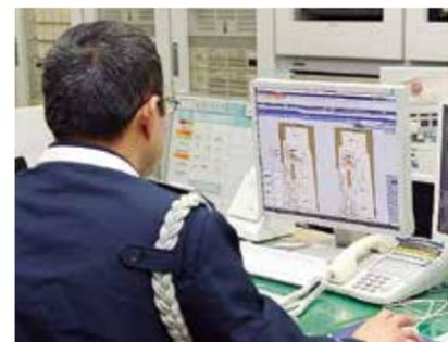
高松シンボルタワーの中央監視防災センターに設置されているsavic-net FX2 セキュリティ。建物内の各部屋の出入り口に設置された非接触ICカードリーダーと連動し、在／不在（警戒／非警戒）状況などを入退室管理システムとして一元管理している。
