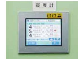
地震制御盤内部にはTriconexの安全計装コントローラが組み付けられている。また盤面に取り付けられた表示器には、地震センサが検知した地震情報が表示される。
