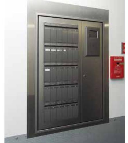
中央監視防災センターに設置されているキーボックス。カードを使わず、鍵で出入り口の開閉を行っているテナントから鍵を預かるために設置されている。鍵の貸出時の認証にはカードを用いる。
