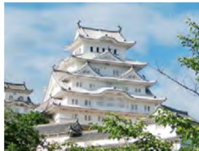
屋根瓦の目地にも漆喰が使われている姫路城。外壁の漆喰塗りは昭和の大修理で3mmから約30mmへと厚く塗り替えられた。
