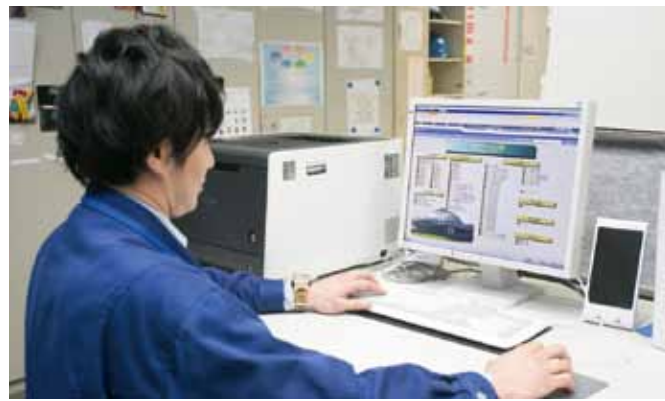
防災センターに中央監視装置として設置されているsavic-net FX2。
