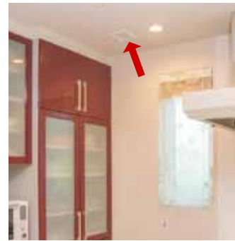
リビング(左)、キッチン(右)など各所に配置された温風、冷風の吹出し口。空調の効果や、居住者への風当たりなどを考慮した設置位置で設計されている。
