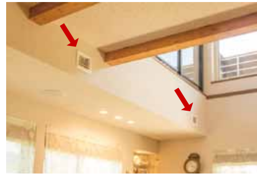
リビング(左)、キッチン(右)など各所に配置された温風、冷風の吹出し口。空調の効果や、居住者への風当たりなどを考慮した設置位置で設計されている。
