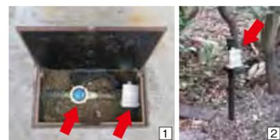
① 西島に設置された電子式水道メーター(左)とSigfox用無線発信機(右)。② 確実なデータ送信が行えるよう、設置時に電波の状況によって無線発信機の場所や高さを調節している。
