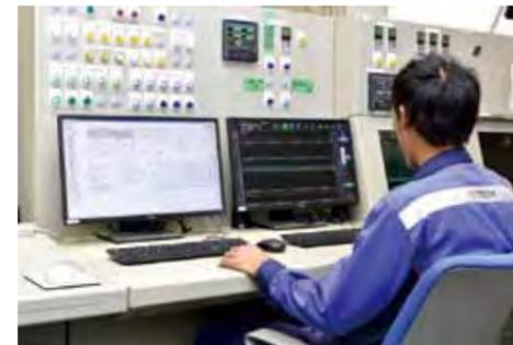
中央監視室に設置されたBiG EYESの端末。監視モデルを作成するコンフィギュレーション画面(左)とトレンド監視ビューア(右)。
