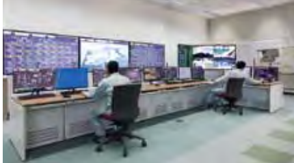
忌部浄水場内にある中央監視室。市内250施設・約4400台の機器の状態を遠隔で一元監視している。
