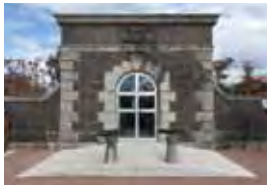
創設時の施設の一つである旧床几山（しょうぎざん）配水池は、登録有形文化財に指定されている。
