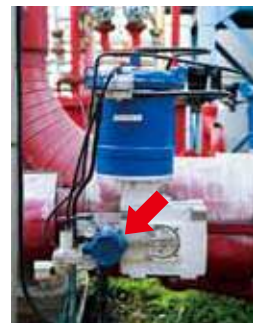
ソーダ電解設備の水素圧力の調整に用いられているアズビル製バルブに取り付けられたスマート・バルブ・ポジションナ。
