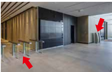
オフィスフロアへの入り口に設置されたセキュリティゲートと来訪者管理システムの無人発券機。
