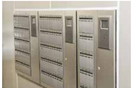
商業テナントの鍵を管理する鍵管理ユニット(キーボックス)。
