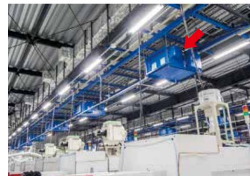
A1工場に設置された天井つり下げ型のTRION。工場の4エリアに計72台を導入。マシニングセンタなどから発生し、空気中に浮遊するオイルミストを集塵し、清浄した空気を工場内に循環させている。
