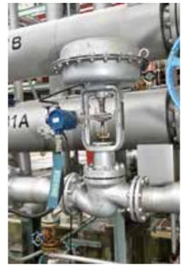
スチレンモノマー製造設備で稼働するスマート・バルブ・ポジションナとトップガイド形単座調節弁。バルブの動作にかかわるデータがポジションナからValstaffに送信され、異常の兆候を速やかに検知できるようになっている。
