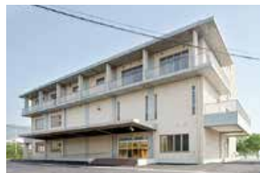
大津市企業局 施設部 浄水管理センター
