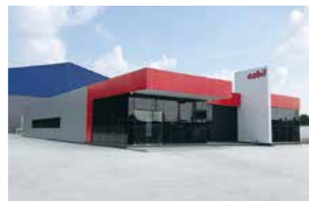
ラヨーン県に新設したソリューションアンドテクノロジーセンター。
