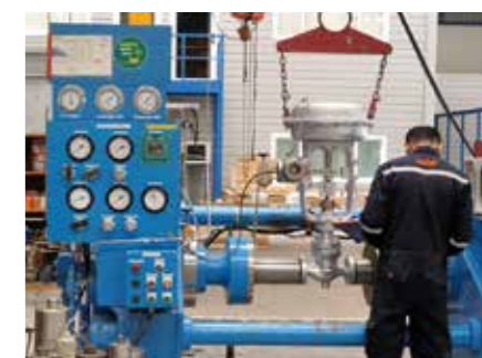
開放点検・修理が完了したバルブは、サイズに応じた耐圧・気密試験を実施して健全性を確認する。
