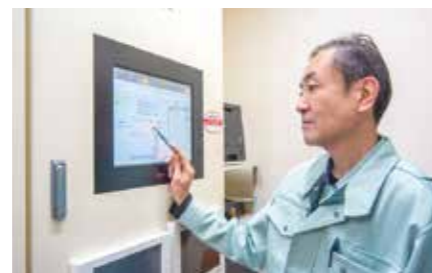
九段小学校・幼稚園の施設全体の空調を中央集中型で管理しているsavic-netFX2compact。この中央監視装置がアズビルのBOSSセンターと接続し遠隔から施設の設備の状態を監視する。
