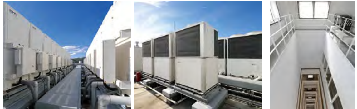
新本庁舎屋上に設置された電気式ヒートポンプ(左)とガス式ヒートポンプ(右)。電気による空調に加え、ガス空調を併用することで電力需要と電気の基本使用料を抑制することができる。
