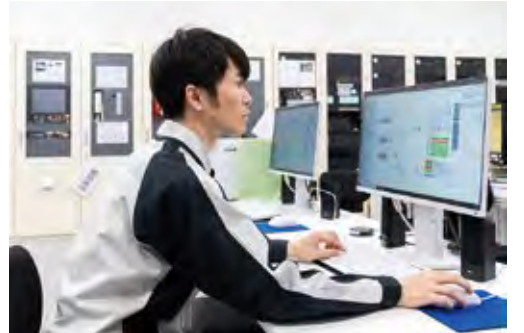
ビル内防災センターに設置されたsavic-net G5の監視端末。
