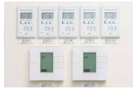
診察室や処置室の室圧を確認できる室圧モニタ。室外と比べてマイナス表示されており、陰圧になっていることが確認できる。
