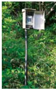
確実なデータ送信が行えるよう、電波の状況によって無線通信端末の設置場所や高さを調節している。
