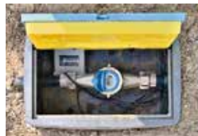
アズビル金門の電子式水道メーターと無線通信端末。水道メーターの交換のタイミングで無線通信端末を取り付け、ボックス内に収納している。
