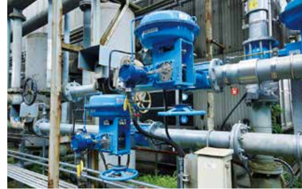
エア減圧制御に用いられ、工場ごとのエアの調節を行う偏心軸回転形調節弁。
