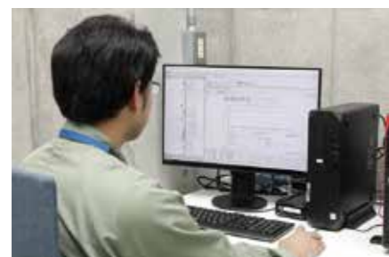
計器室に設置されたIFOのモニター画面。フィールド機器の稼働状況を現場に赴かなくても計器室から確認できる。
