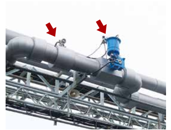
ボイラ側で蒸気送出直後の圧力を制御する蒸気調整弁のFloWing™ 偏心軸回転調節弁(右)と蒸気流量計 STEAMcube™(左)。
