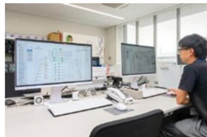
庁舎内の設備・機器を監視・制御する中央監視装置savic-net G5。熱源設備の監視画面では、直感的で見やすいグラフィックで設備稼働状況を確認することができる。
