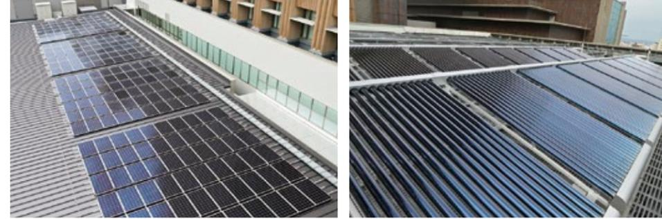
日照時間の長い地域特性を活かし、庁舎建物南側に太陽光発電パネル(左)と太陽熱収集器(右)を設置。太陽熱は食堂の給湯などに利用されガス利用量の削減に役立ち、太陽光発電は庁舎全体の電力の2%を賄っている。
