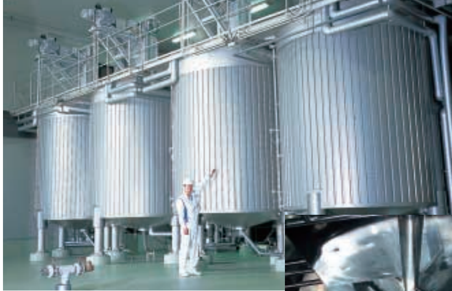
灘工場内に設置された発酵タンク
