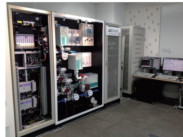
写真2 CSSC納入のIndustrial-DEOシステムと化学模擬プラント
