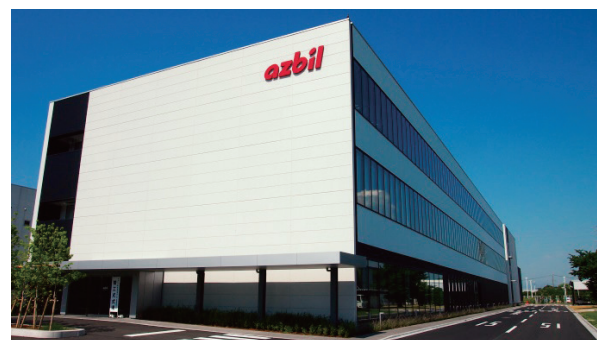
図1 アズビル(株)湘南工場に新設された生産棟
