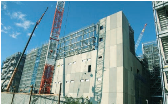
図2 建設中の新実験棟2(2021年12月撮影)
