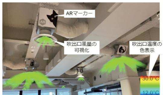
図18 ARによる吹出口風量と温度の可視化
