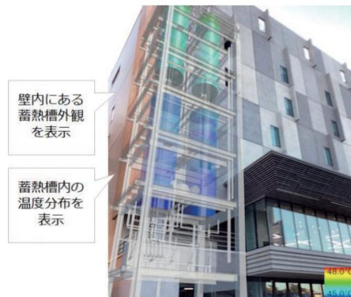
図19 ARによる蓄熱槽温度の可視化
