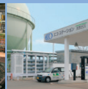
小松ガス株式会社 (L-CNG方式エコステーション)
