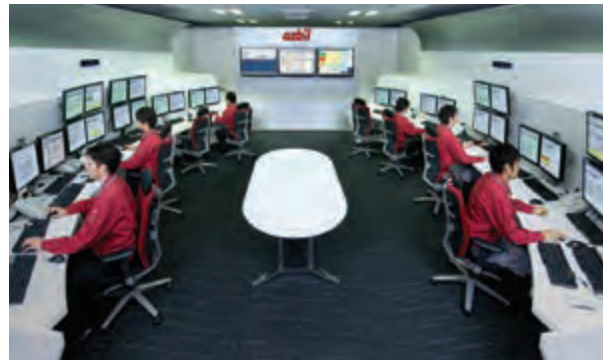
ビル・工場の総合監視を行う遠隔監視センター
