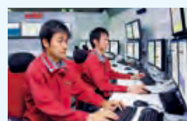
ビル・工場の総合管理・保全を行う 遠隔監視センター(日本)
