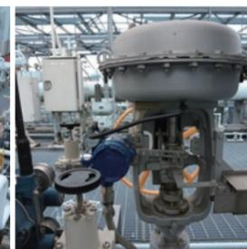
ひびきLNG基地とDx Valve Cloud Serviceを構成する当社スマート・バルブ・ポジション
