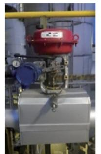
調節弁稼働データはクラウドへ送信され、CBMによる調節弁の整備計画策定を行う
