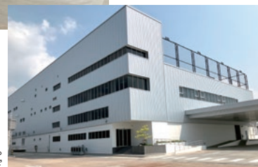
竣工したタイ新工場。 電磁流量計他の生産ラインを構築予定
