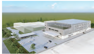
建設中のタイの新工場棟イメージ。工業市場向け製品の生産を計画
