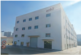
稼働を開始した大連の新工場棟。進化したコントロールバルブ生産体制を構築中
