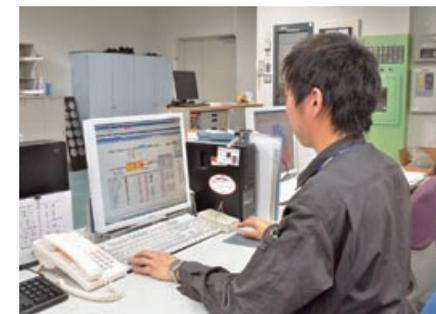
施設部設備グループ内に設置されたsavic-net™ FXの監視画面。黄色いビル各棟の設備の状況を集中監視している。
