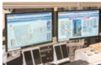
中央監視室でビル全体のセキュリティ状況や、空調等の設備運用状況を一括で監視することができる統合型建物管理システム「savic-net FX2セキュリティ」
