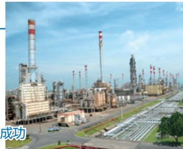
プルタミナ社様は、1957年にインドネシア政府によって設立され、2001年に民営化された同国最大規模の石油・ガス関連企業です。同社が参加したのが、日本が構築、実施している二国間クレジット制度 (JCM) を活用した実証事業\*1です。プルタミナ社様が所有する、中部ジャワ州チラチャップにある第IV製油所内の動力プラントにアズビル株式会社の制御高度化ソリューション「SORTIA™」を導入しました。発電と製油所内で使用する高圧蒸気を製造する水管ボイラは、その特性によって効率差があるため、各ボイラの負荷の配分はCO<sub>2</sub>を削減するために非常に重要ですが、各ボイラの負荷を手動調整するのは困難でした。今回、負荷配分を最適化し全体効率を最大化する高度制御を構築し、3万5,000トン (10カ月) のCO<sub>2</sub>削減を達成。燃料削減効果は3億円に上ります。さらに、チューニングによ
