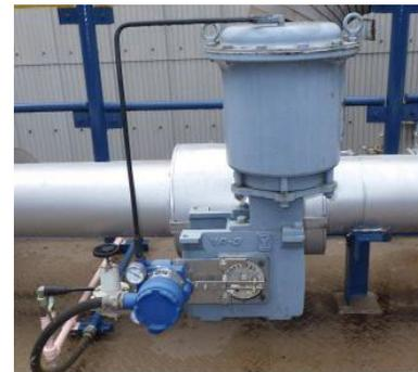
スマート・バルブ・ポジショナが収集する調節弁稼働データはPLUG-IN Valstaff™を経由してクラウドへ送信され、バルブの健全性確認を行う。
